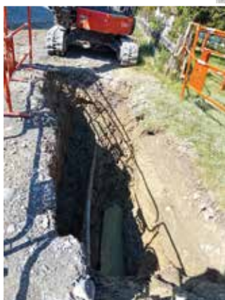
Intervention d'urgence sur des fuites d'eau potable
