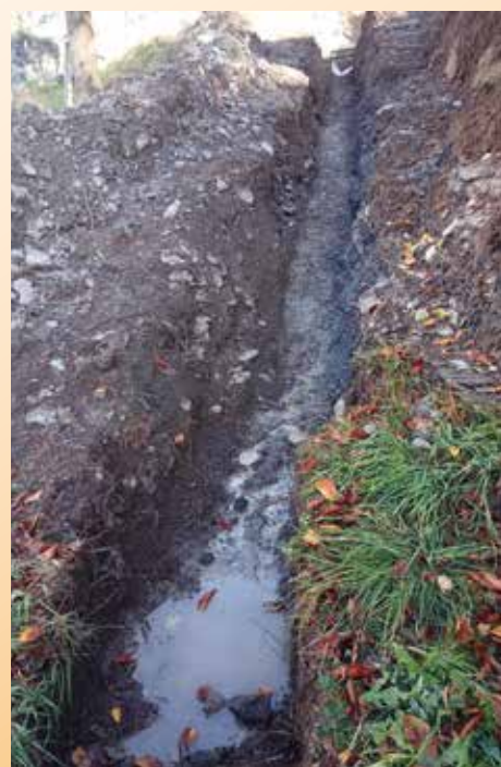
UN DRAIN VISIBLE QUI CAPTE L'EAU VERS UN DRAIN ENTERRÉ
