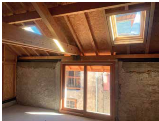
ET APRÈS TRAVAUX
