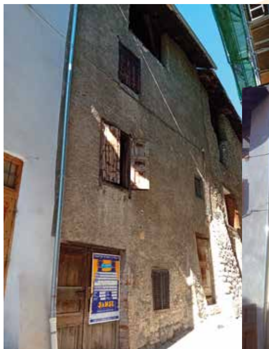
LA FAÇADE AVANT TRAVAUX
