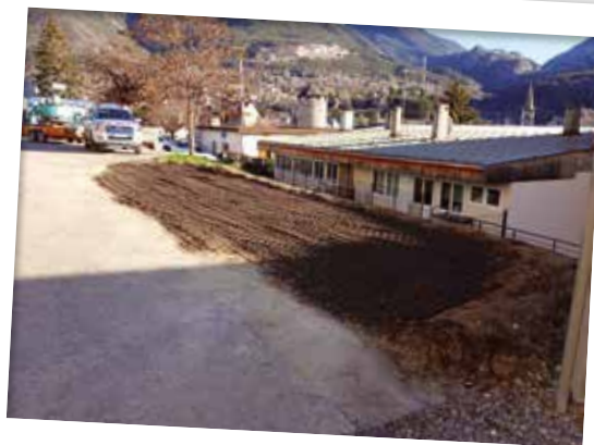
CRÉATION DE PLACES DE STATIONNEMENT À LA MAISON DE SANTÉ
