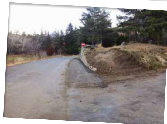
RÉPARATION DU MUR EFFONDRE ROUTE DE LA VISTE
