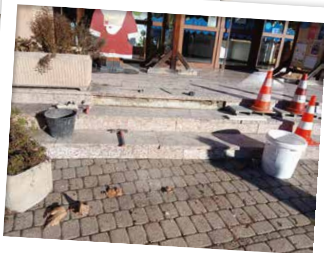
RÉPARATION DES MARCHES DE LA PLACE SALVA
