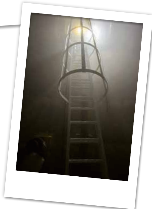
SÉCURISATION DES RÉSERVOIRS D'EAU
