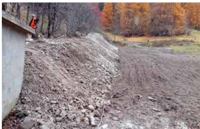
REMISE EN ÉTAT DU SITE
