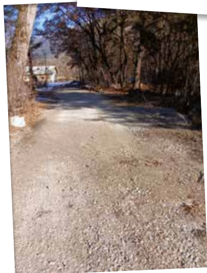
REMISE EN ÉTAT DU CHEMIN DES SITELLES
