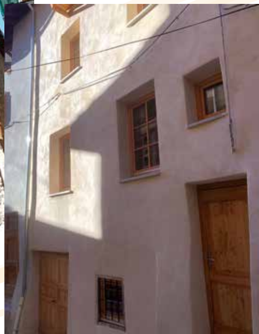
ET APRÈS TRAVAUX
