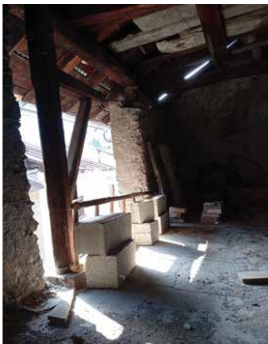
LE BALCON AVANT TRAVAUX
