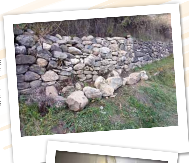
REMONTAGE DU MUR DE SOUTÈNEMENT DE LA ROUTE DE LA GARE APRÈS DE FORTES PLUIES
