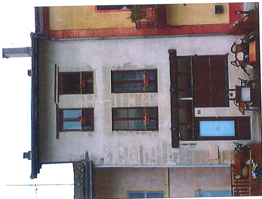
Exemples de restauration de façade au mortier de chaux au nu des pierres d'encadrement
