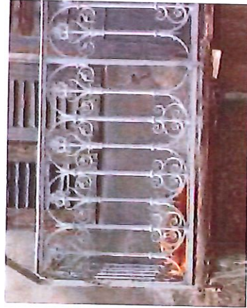
Balcon XIXe en fer sur consoles, garde-corps en fer et fonte
