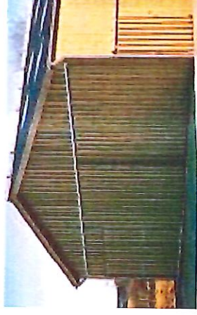
Bardage bois (murs et portes) et bardage métallique de couleur grise
