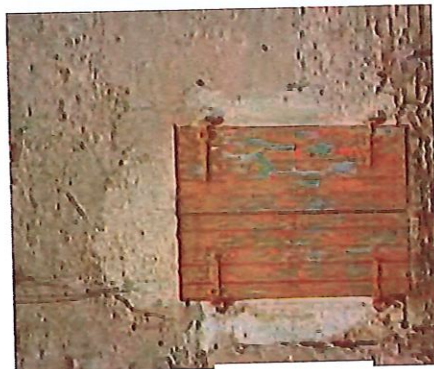
Exemples de restauration de façade au mortier de chaux au nu des pierres d'encadrement
