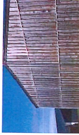
Bardage bois pose verticale et pose horizontale
