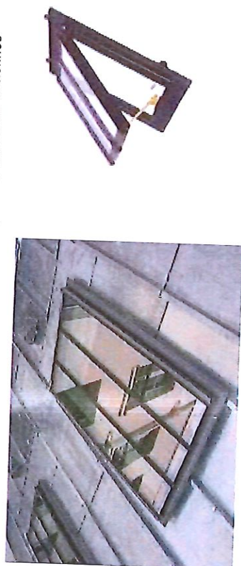
Exemple de châssis de toit en fonte inspiré des tabatières anciennes
