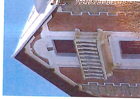
Balcon début XXe en pierre sur consoles, garde-corps à balustres
