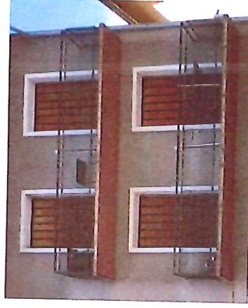
Balcon années 60 en béton, garde-corps en fer
