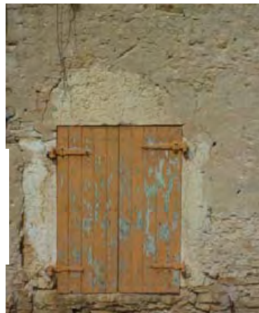
Exemples de restauration de façade au mortier de chaux au nu des pierres d'encadrement
