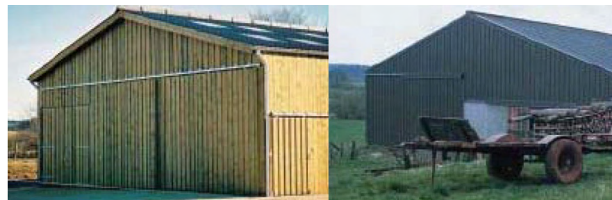
Bardage bois (murs et portes) et bardage métallique de couleur grise
