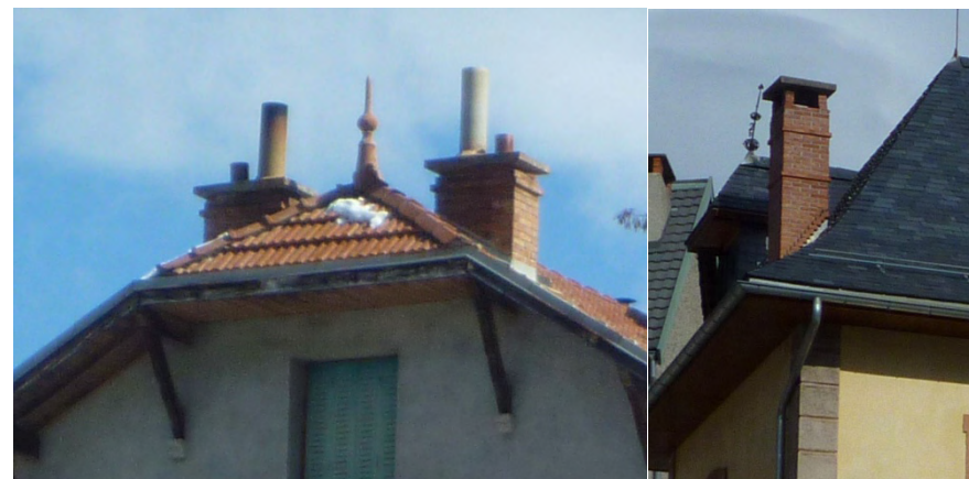
Toiture à demi-croupe, couverture en tuiles mécaniques
