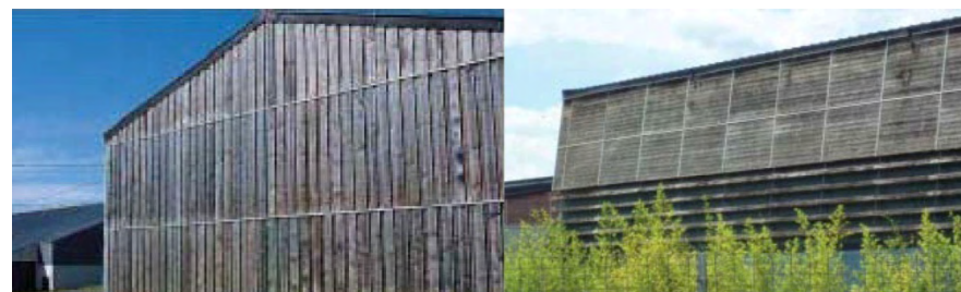
Bardage bois pose verticale et pose horizontale
