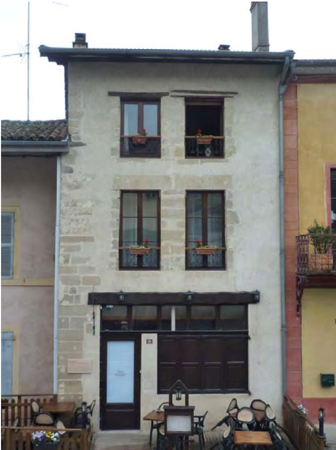
Exemples de restauration de façade au mortier de chaux au nu des pierres d'encadrement
