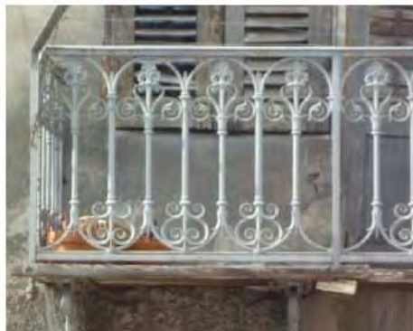
Balcon XIXe en fer sur consoles, garde-corps en fer et fonte
