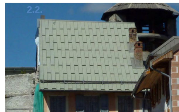
Toiture à deux pans, couverte en bac acier
