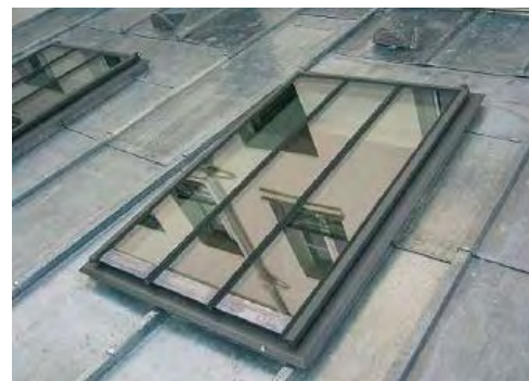
Exemple de châssis de toit en fonte inspiré des tabatières anciennes
