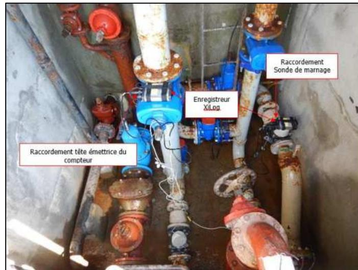
Figure 21 : Exemple de mise en place du matériel de mesure
