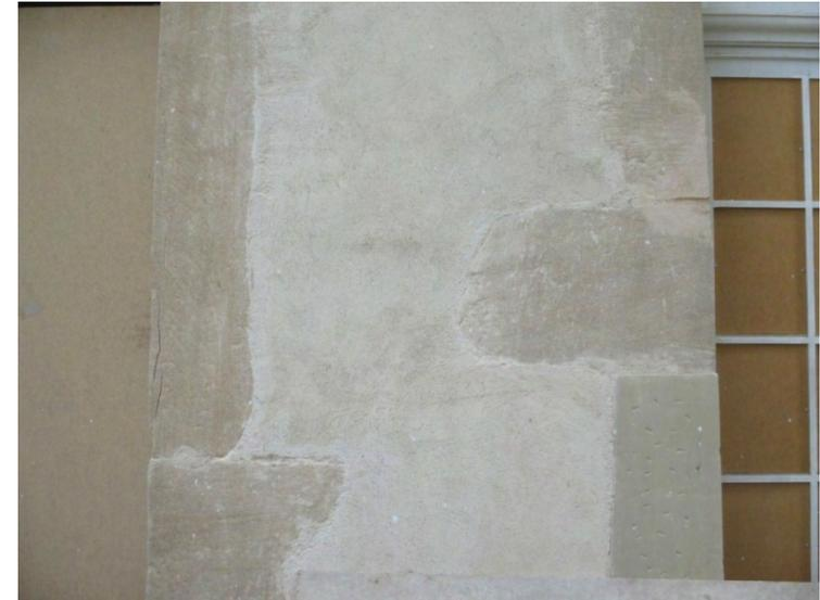
*Exemples d'enduit chaux traditionnel couvrant au nu exact des pierres d'encadrement*
