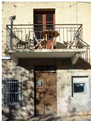
Balcon années 30 en béton sur consoles avec garde corps en fer
