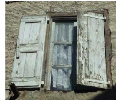
*Exemples de fenêtres bois grands carreaux style XIXe avec ou sans volets bois en planches verticales assemblées sur cadre et pentures en fer forgé*
