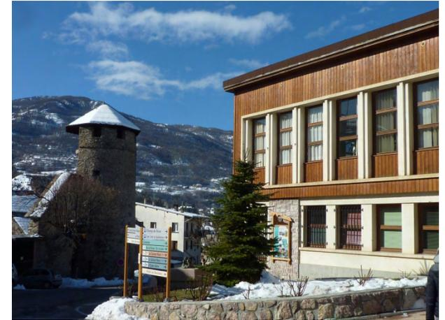
*Immeuble place Albert : conservation des encadrements de baies en béton blanc, enduit courant texturé type projeté à la tyrolienne, balcons en béton*
