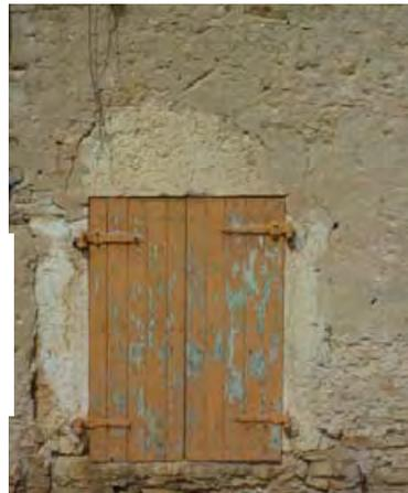
*Exemples d'enduit chaux traditionnel couvrant au nu exact des pierres d'encadrement*
