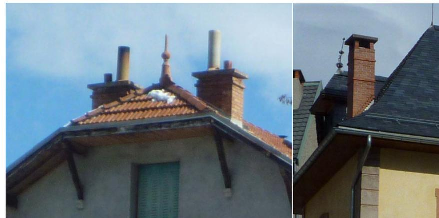
*Toiture à demi-croupe, couverture en tuiles mécaniques*
