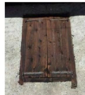
*Exemples de fenêtres bois grands carreaux style XIXe avec ou sans volets bois en planches verticales assemblées sur cadre et pentures en fer forgé*
